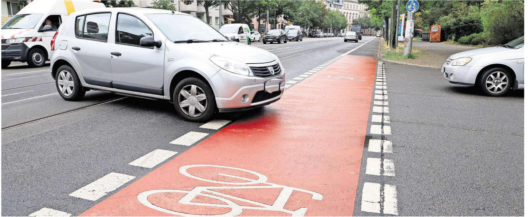
Unfallschwerpunkt Dresdner Straße/ Crusiusstraße: Die rot markierte Radfuhrt soll Radfahrer besser vor Unfällen mit abbiegenden Autos schützen.
