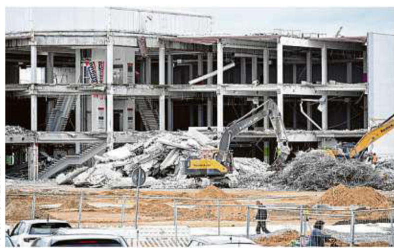
Noch bis Ende November soll der Rückbau in Groß Gaglow erfolgen. Foto: MICHAEL HELBIG
